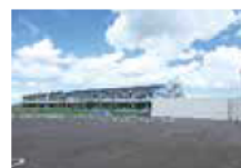
震災遺構 浪江町立請戸小学校
