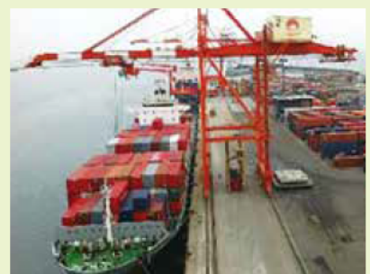
仙台塩釜港 (仙台港区中野地区)
