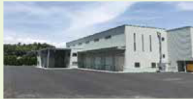
カントリーエレベーター
