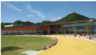
▲大熊町役場庁舎への太陽光発電システムの導入
