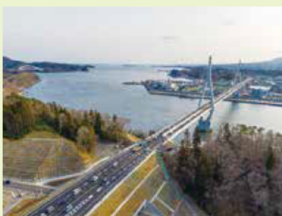
復興道路 (三陸沿岸道路 (気仙沼港～唐桑半島))
